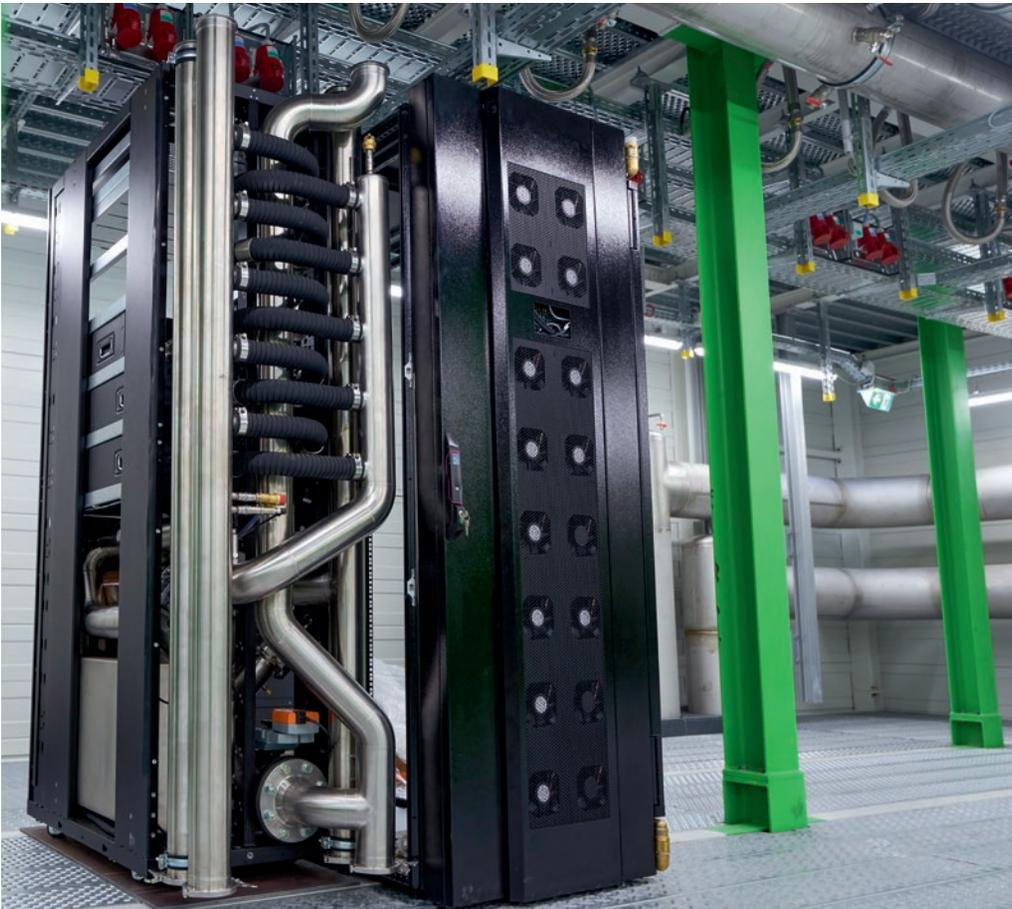
Power auf engstem Raum: Über 1 MW Kühlleistung für direkte Chipkühlung mit Wasser.
