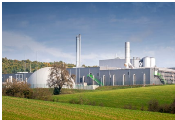
Bioabfallvergärungsanlage der AVR BioTerra GmbH & Co. KG in Sinsheim
