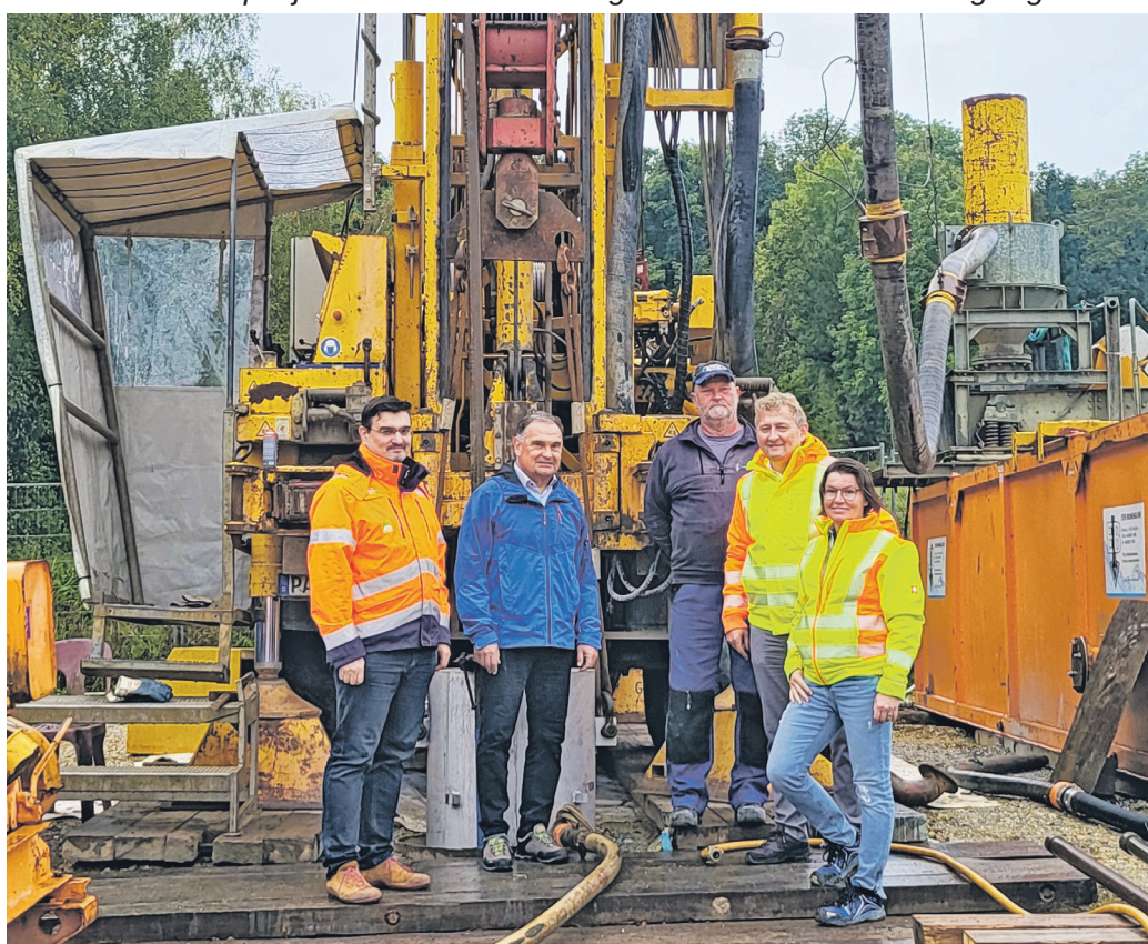
Dr. Matthias Zeithöfler vom Deggendorfer Planungsbüro IFB Eigenschenk, Franz Enzensberger (Gemeinde Eichendorf), Bürgermeister Josef Beham, Bauleiter Franz Schneider von der Firma Eder Brunnenbau aus Hebertsfelden und Sabine Forstner (Gemeinde Eichendorf) bei der Brunnenbohrung Ende 2024.
